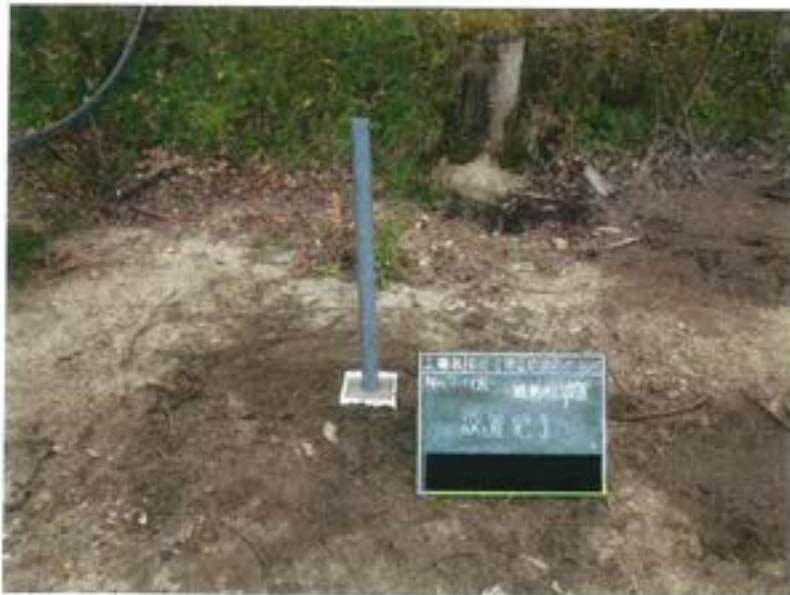
第Ⅲ-1埋立地調査ボーリング No. 7付近 観測井戸設置完了
