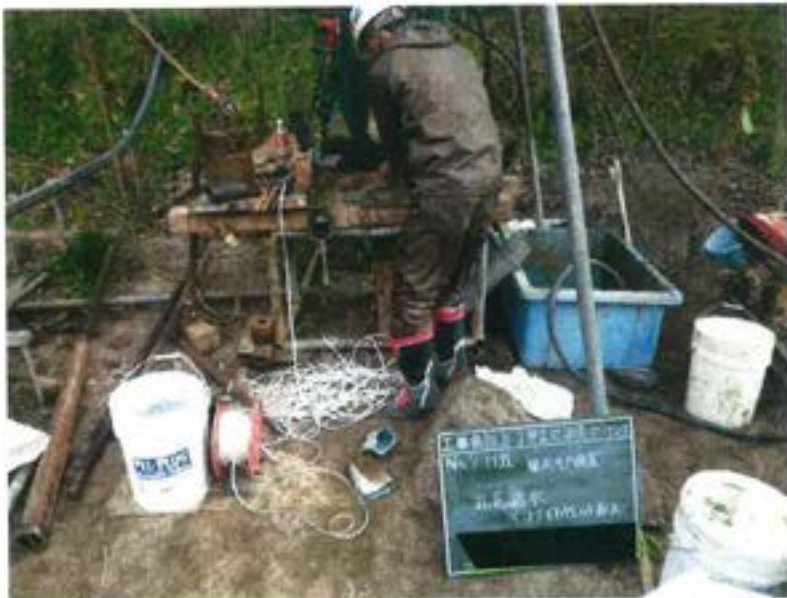
第Ⅲ-1埋立地調査ボーリング No. 7付近 観測井戸設置 孔底遮水 ペントナイトペレット投入
