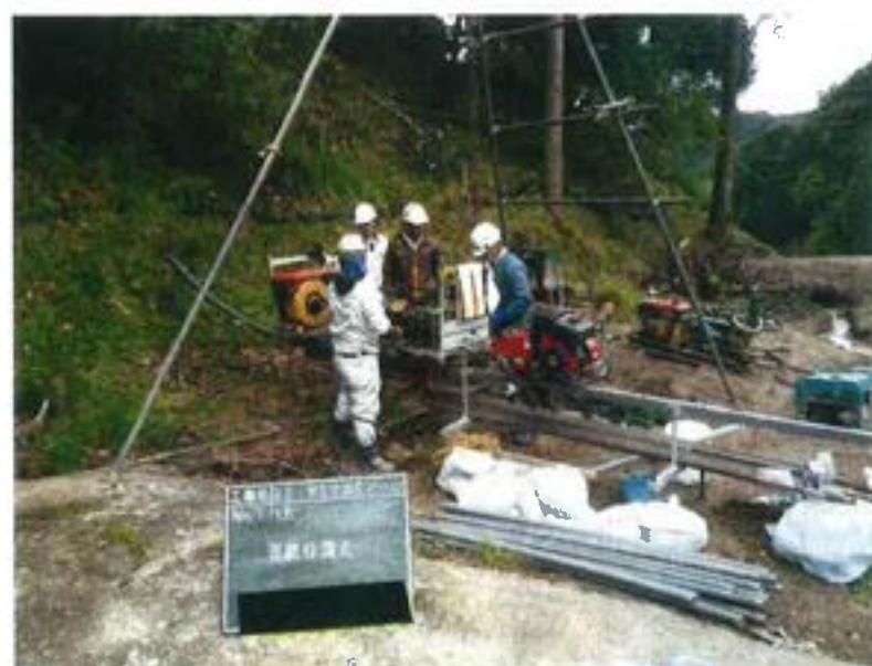
第Ⅲ-1埋立地調査ボーリング No. 7付近 資機材撤去
