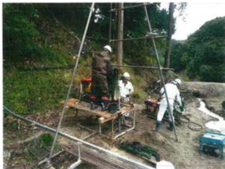
第Ⅲ-1埋立地調査ボーリング No. 7付近 資機材撤去
