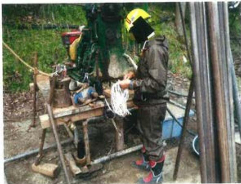
第Ⅲ-1埋立地調査ボーリング No. 7付近 水位確認状況
