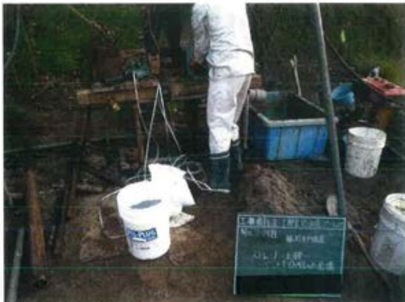
第Ⅲ-1埋立地調査ボーリング No. 7付近 観測井戸設置 有孔管上部 ベントナイトベレット充填
