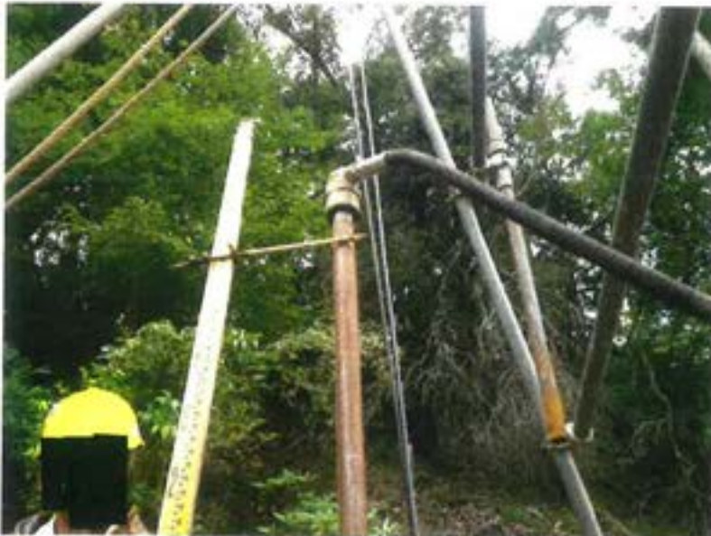
第Ⅲ-1埋立地調査ボーリング
