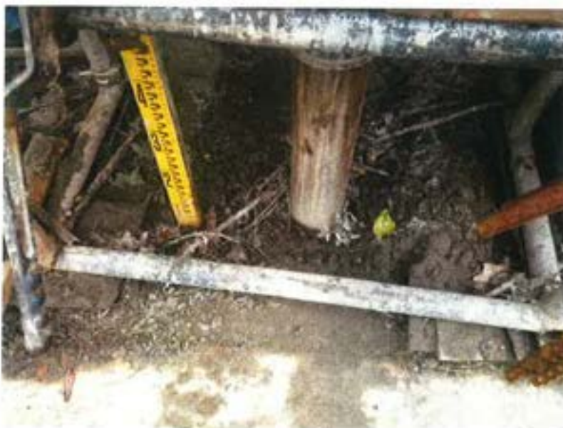
第Ⅲ-1埋立地調査ボーリング
