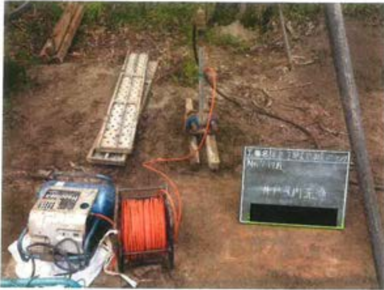
第Ⅲ-1埋立地調査ボーリング No. 7付近 観測井戸設置 井戸孔内洗浄
