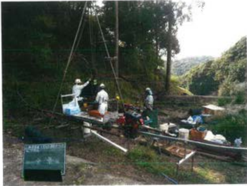
第Ⅲ-1埋立地調査ボーリング No. 7付近 全景
