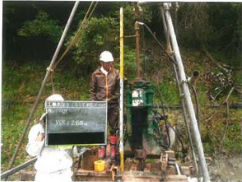
第Ⅲ-1埋立地調査ボーリング
