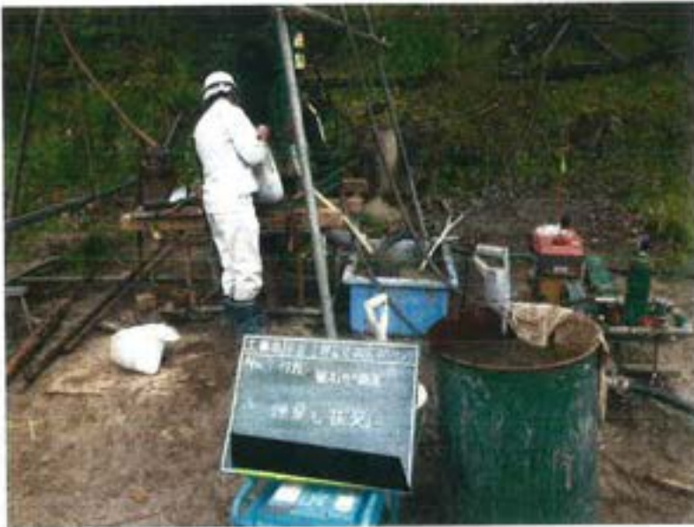
第Ⅲ-1埋立地調査ボーリング No. 7付近 観測井戸設置 埋戻し状況
