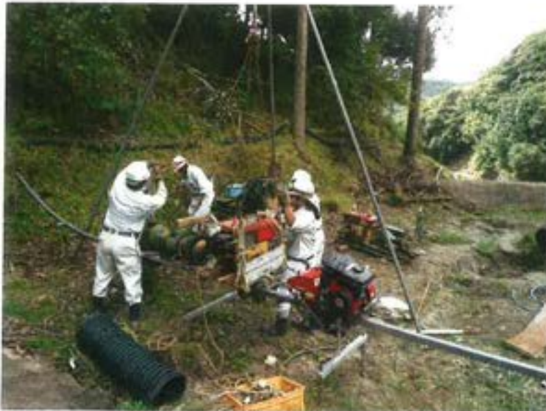
第Ⅲ-1埋立地調査ボーリング No. 7付近 ボーリングマシン搬入・仮設状況
