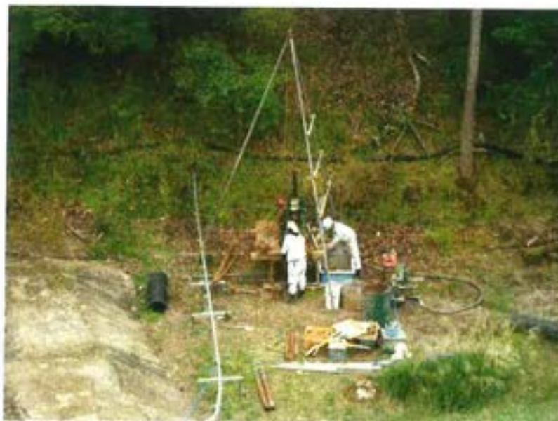
第Ⅲ-1埋立地調査ボーリング No. 7付近 ボーリングマシン仮設状況
