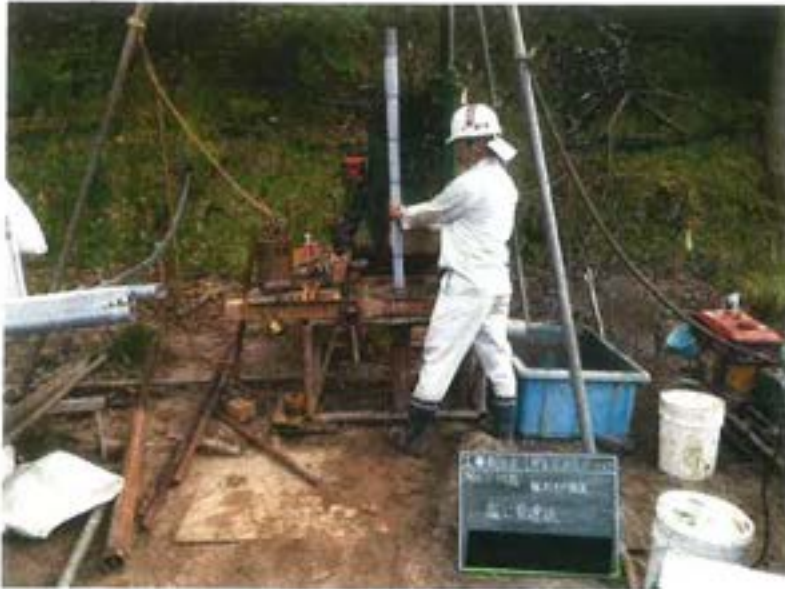
第Ⅲ-1埋立地調査ボーリング No. 7付近 観測井戸設置 塩ビ管達込
