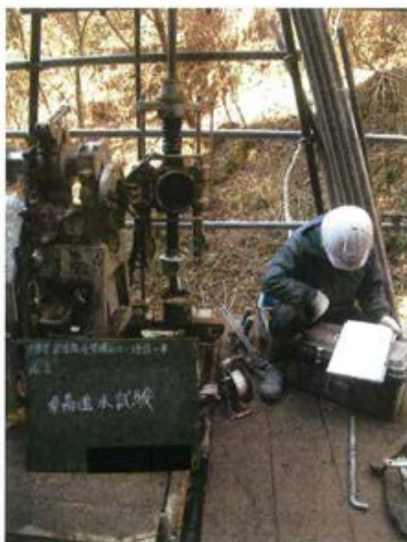
現場透水試験(5.00~7.00m)
