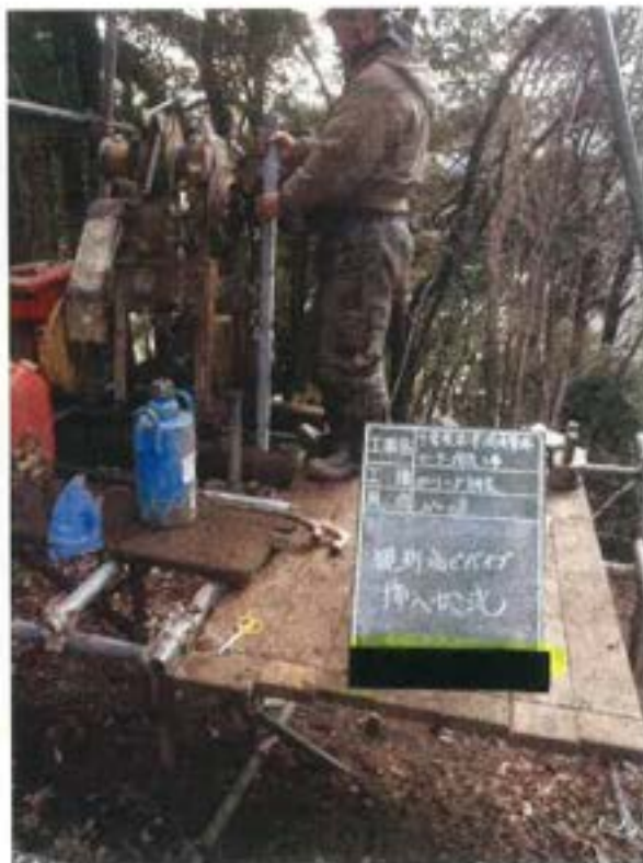
塩ビ管挿入状況
