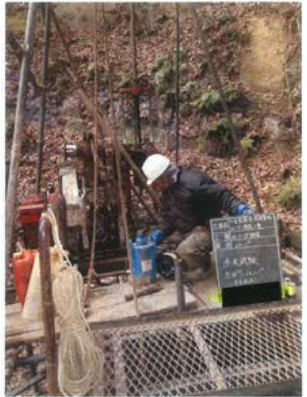
現場透水試験 7.90~10.00m
