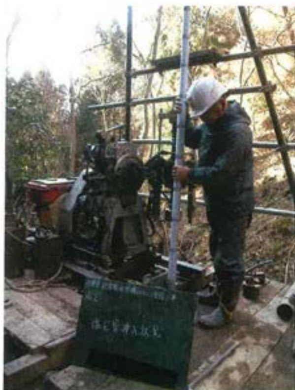
塩ビ管挿入状況
