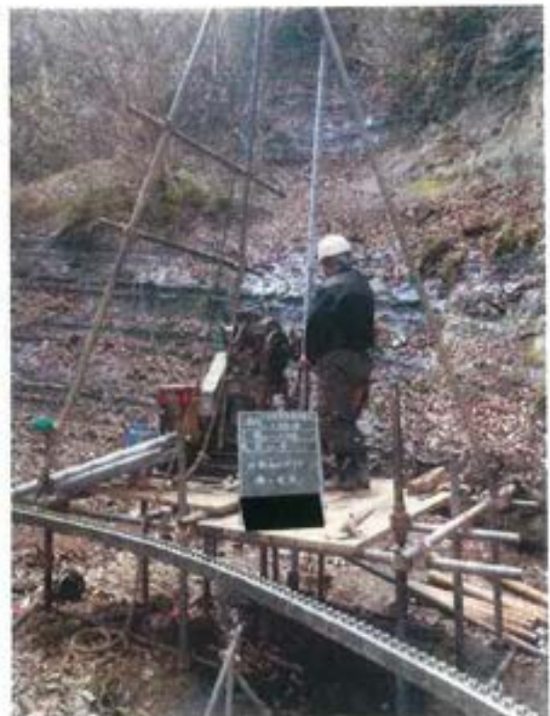
塩ビ管挿入状況
