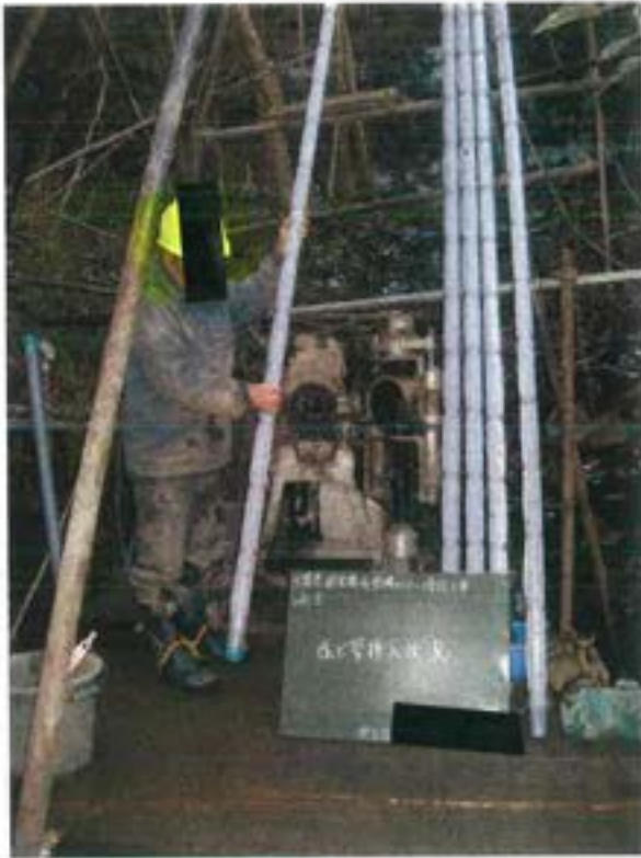
塩ビ管挿入状況
