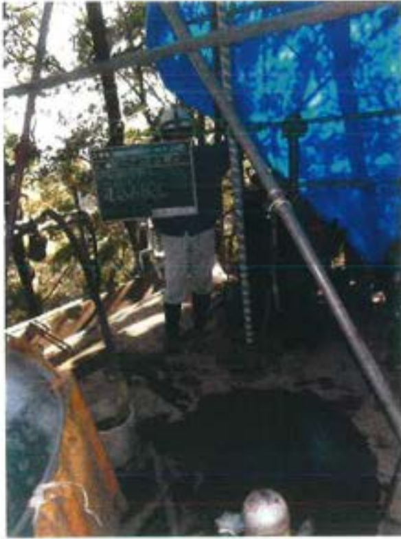
塩ビ管挿入状況
