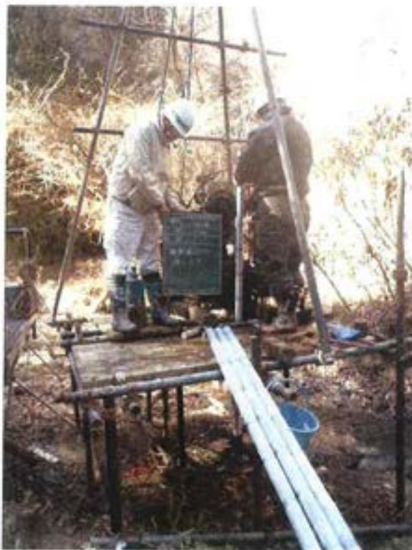
塩ビ管挿入状況
