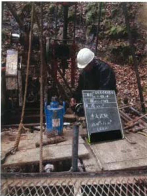
現場透水試験 10.00~12.00m
