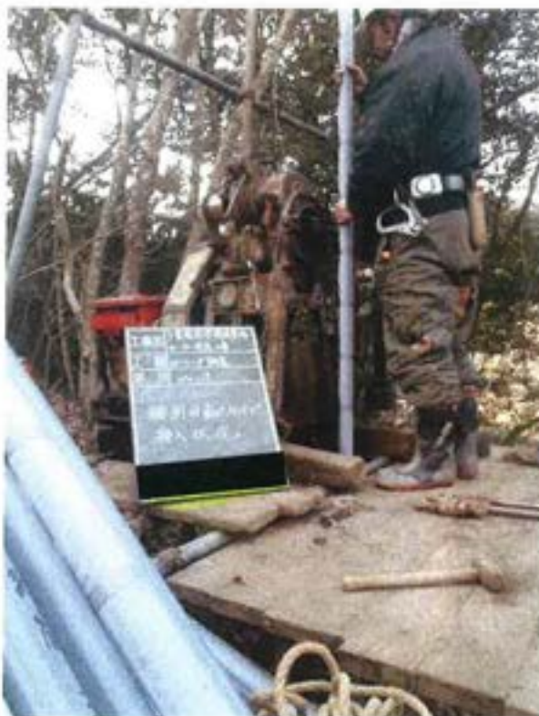
塩ビ管挿入状況
