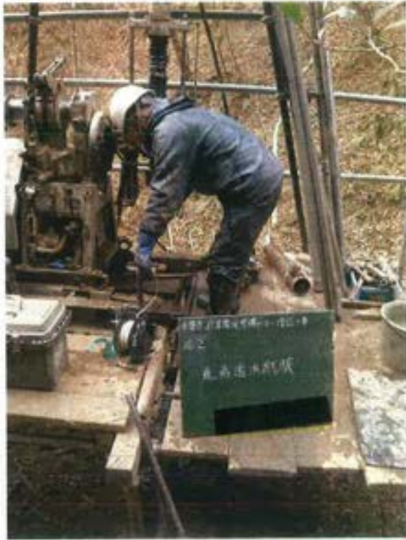
現場透水試験(13.00~15.00m)
